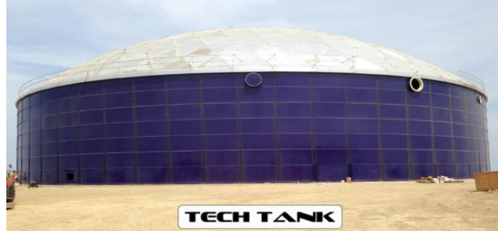
Figura 2 – Reservatório de água potável em aço vitrificado concluído
