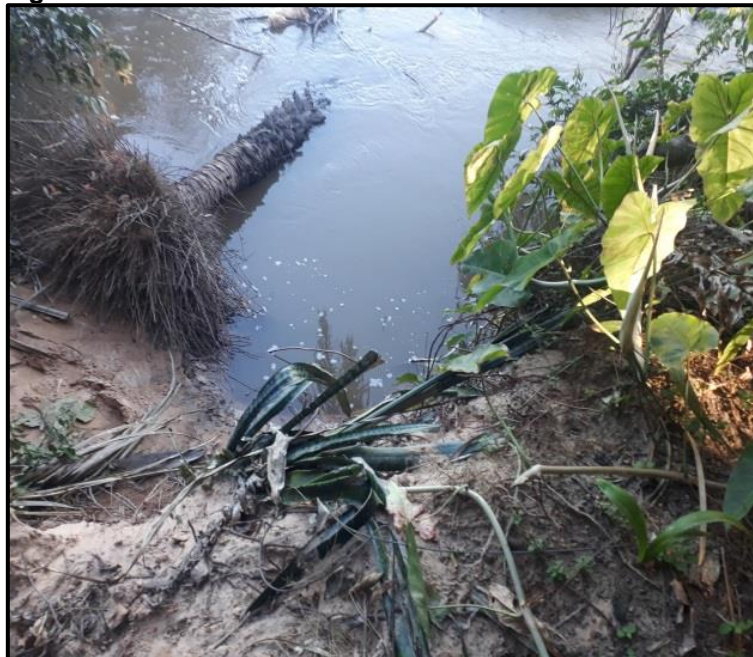
Figura 3 - Erosão no em uma das trilhas do local.
