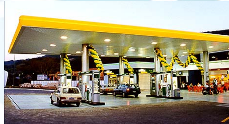
Vazamentos em postos de combustíveis
