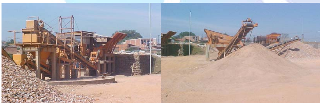
Figura 1. Usina de reciclagem de resíduos.
