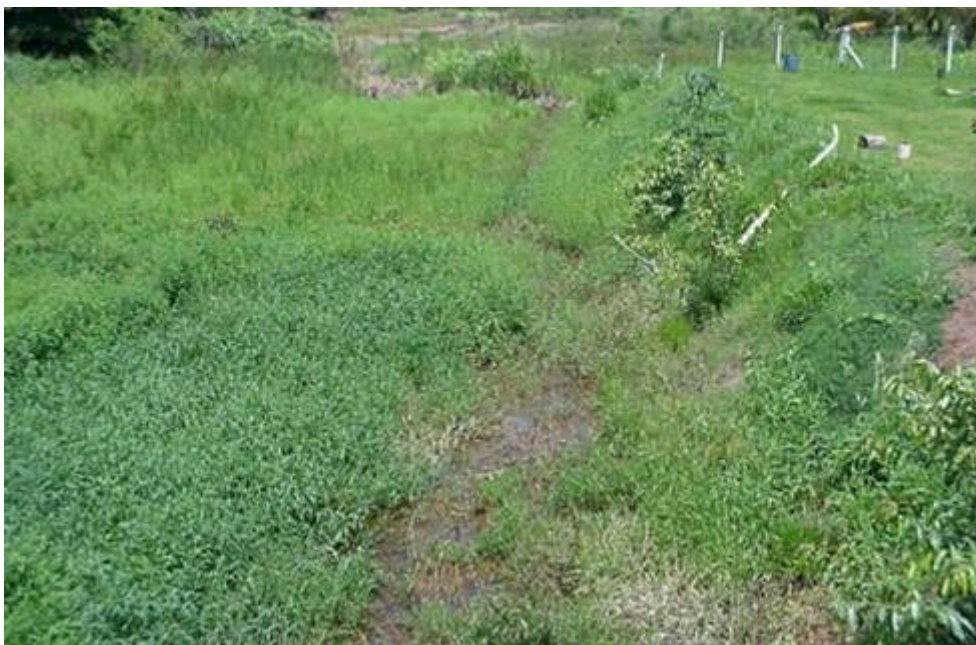
FIGURA 04 - Assoreamento e invasão do corpo d'água pela vegetação. (Localização: Elevação 351 m, Latitude 20^{\circ} 27' 09'' S, Longitude 51^{\circ} 18' 59'' W)
