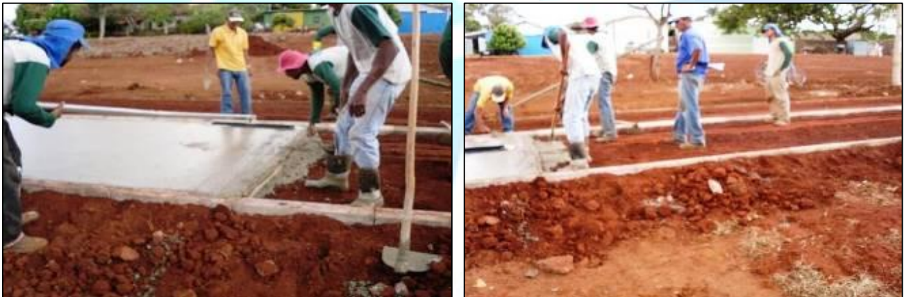
Figura 7. Aplicação e sarrafeamento do concreto. Fonte: Moreira e Fidelis (2009)
